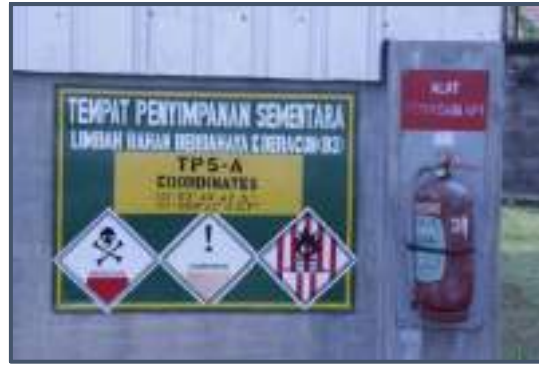
Gambar 4 Ilustrasi Kesiapan Sarana APAR dan Pelabelan pada Tempat Penyimpanan LB3
