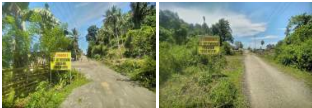
Gambar. 8 Kondisi Akses Jalan Desa Palau – Desa Pomolulu/ Tersus
